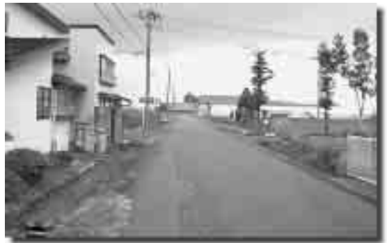
拡幅の請願があった市道静町上小屋幹線
