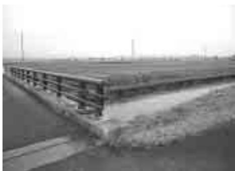
整備が待たれる排水路(大雄・大宮川橋付近)
