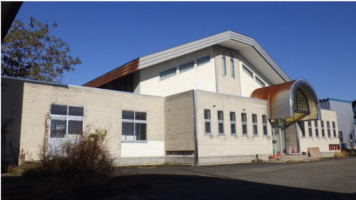
写真2（体育館・渡廊下棟）
