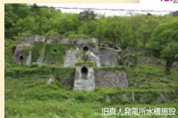
旧真人発電所水槽施設
