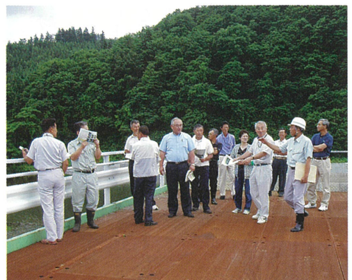
国営平鹿平野農業水利事業皆瀬頭首工の工事現場を視察する農業委員
