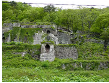
旧真人発電所水槽施設
