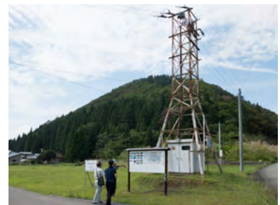
鉱山の送電施設
