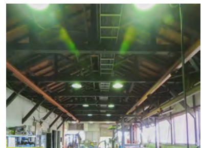
工場棟D内部
