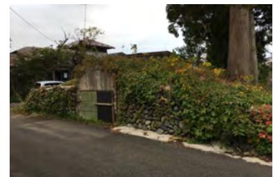
旧平鹿郡立農事講習所地下冷蔵庫
