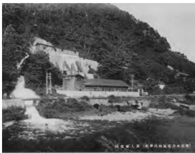
増田水電真人発電所（昭和10年頃）
