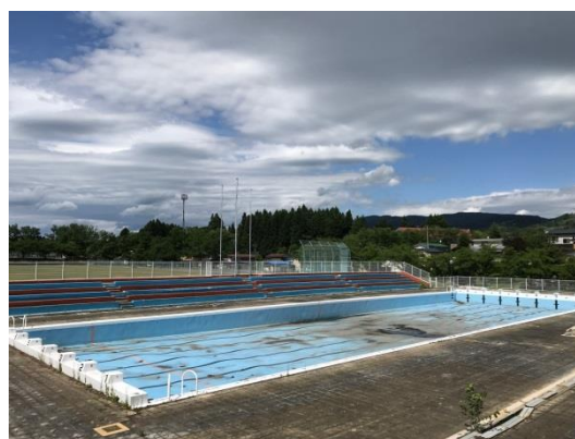
使用ができなくなった大鳥公園市民プール
