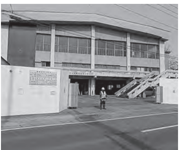
施設の老朽化により 解体工事が進む十文字文化センター
