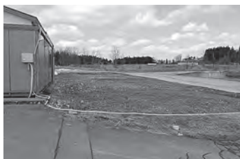
既に現場事務所が立っている旧東部環境保全センター跡地
