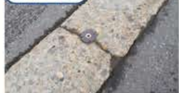
地下水をポンプで汲み上げ、路面に散水して雪を溶かします。
