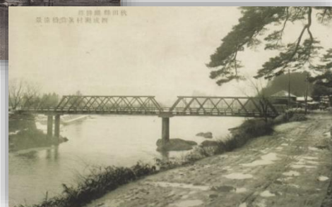
↓昭和26年完成の真人橋 昭和42年に解体
