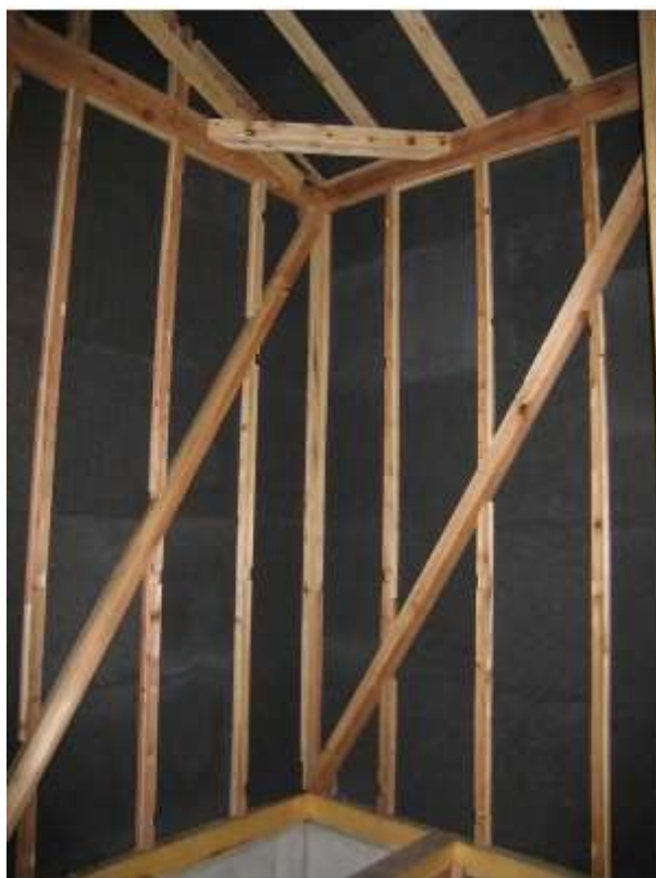
くん炭ボード施工の様子
