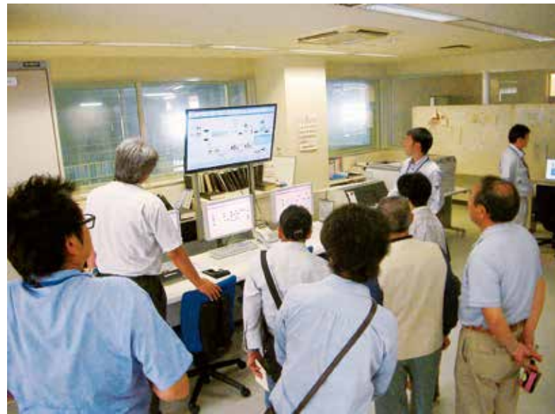
〔大沢浄水場運転監視室〕
