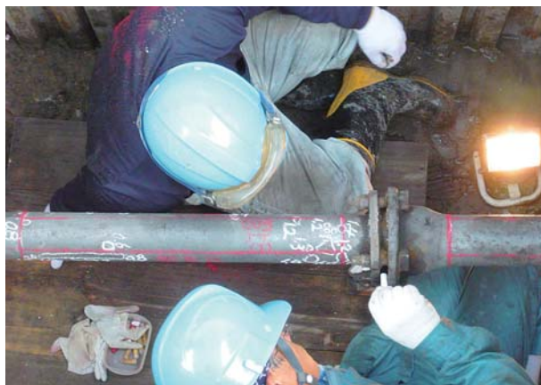
管体調査状況（水道管の腐食状態を調べています。）
