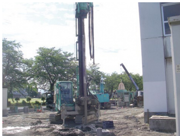
柱状改良工事
