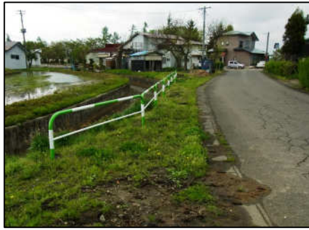
黒川地区会議へ (黒川地内への防護柵の設置 H24.3.21)
