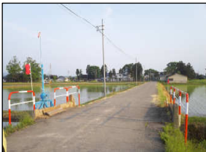
暮らしの道づくり事業 (境町地内への防護柵の設置 H24.3.21)
