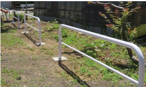
四津屋農村公園防護柵設置
