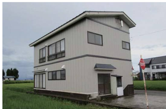
乗阿気構造改善センター外壁改修
