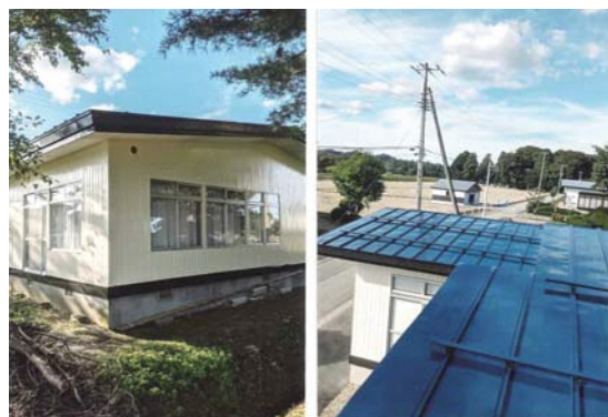
西丁集落会館屋根・外壁塗装
