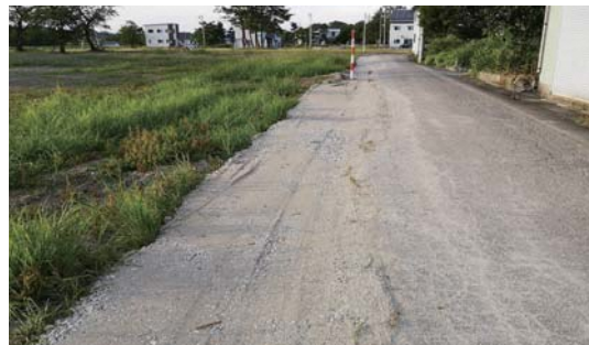
旧こどもセンター前広場の側溝埋戻し
