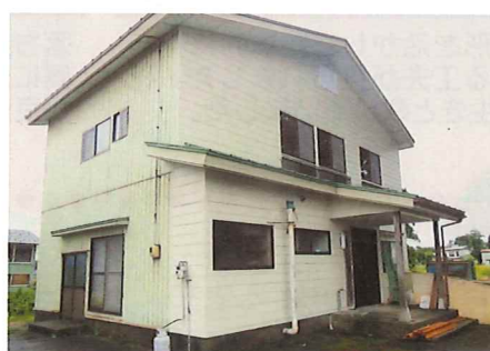
三村集落会館外壁修繕
