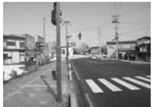
中央線道路・蛇ノ崎橋付近
