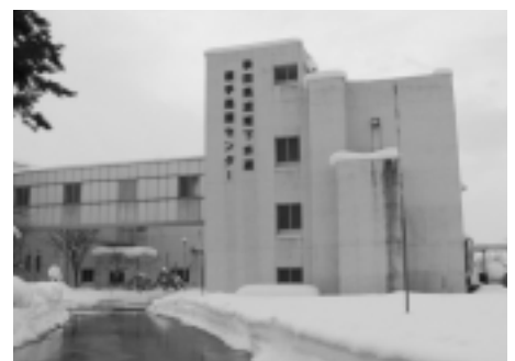
県流域下水道処理センター（横手・黒川）
