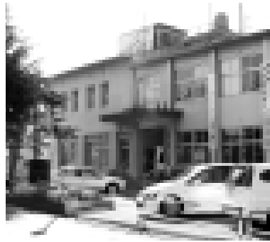
老朽化が進む十文字庁舎
