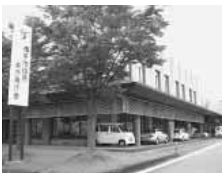
市長公室が入る現在の本庁舎
