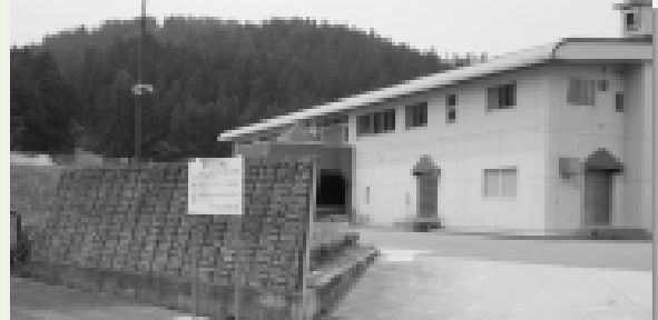
注意喚起の看板が設置された大沢浄水場
