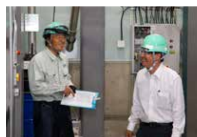
▲発電所内で点検をするスタッフと談笑する藤倉さん(写真右)
