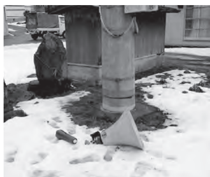
老朽化により落下した防災無線の屋外スピーカー
