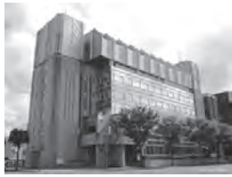
建設から37年が経過した本庁舎
