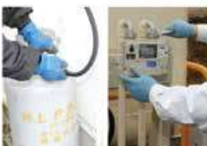
LPガス・灯油機器の施設工事
