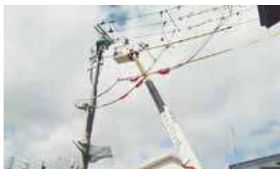
高所作業の様子
