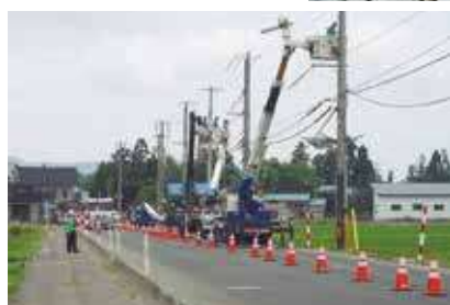
&lt;高所作業車&gt;使用の様子
