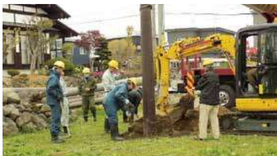
▲安全大会の実技訓練の部 建柱工事
