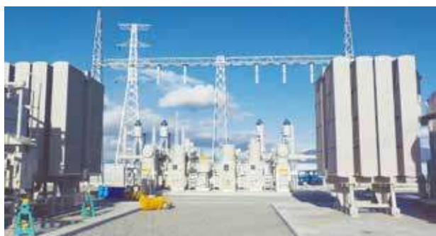
発電電作業現場
