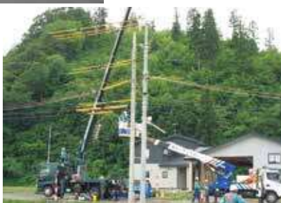
&lt;穴掘建柱車&gt;使用の様子
