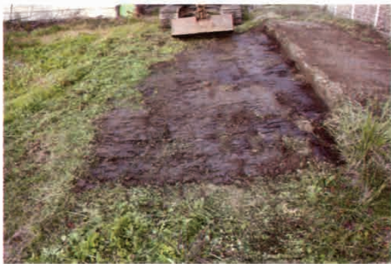
2トレンチ 埋め戻し後(南→)
