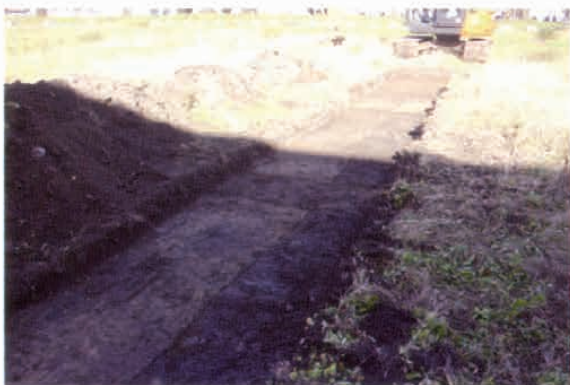
1トレンチ北側 全景(南東→)
