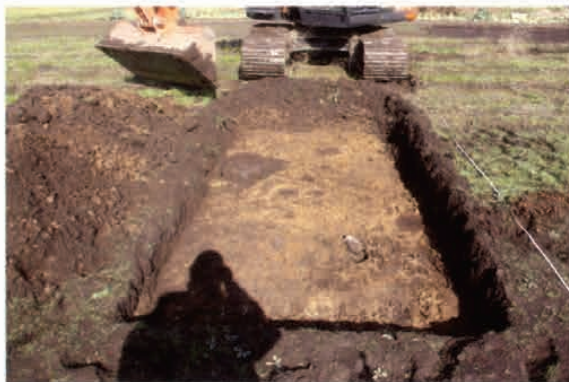
81トレンチ 遺構検出状況(南→)
