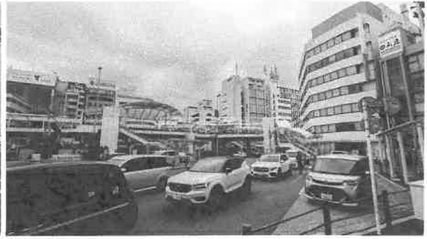
川越駅西口のペデストリアンデッキ
