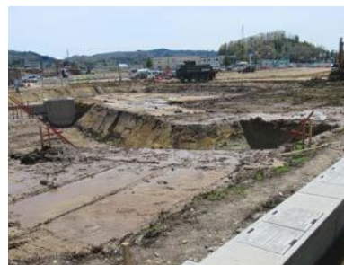
▲柳田工業団地拡張造成工事のようす
