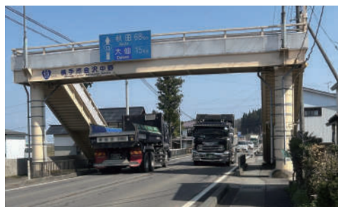
▲新規事業化となり、特に冬期の渋滞緩和が期待される『横手北道路』(写真は横手市金沢中野付近)
