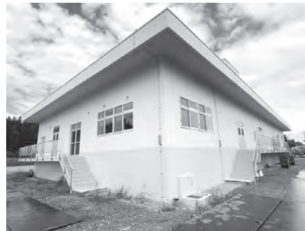
大森浄化センターの外観
