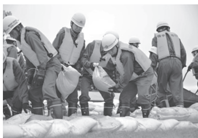
横手市消防団が 積土のう工を行う様子
