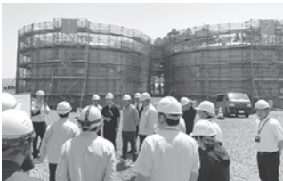
建設が進む雄物川浄水場
