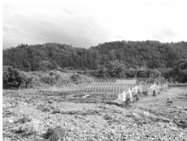
7月の大雨災害で 被害を受けた農業用施設
