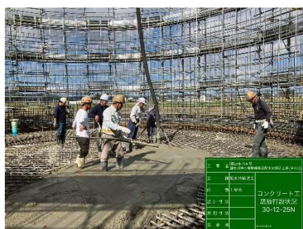
コンクリート打設工
