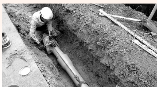
水道管路更新工事の様子
