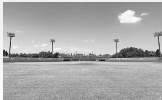
照明設備の改修工事が決定した 十五野公園野球場（平鹿）
