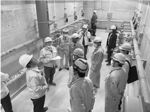
百条委員会による現地確認
