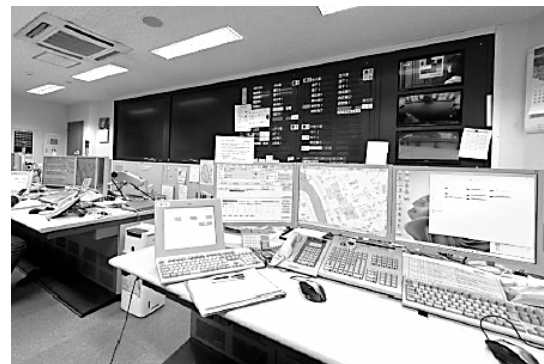
現在運用中の高機能消防指令センター
