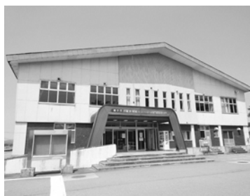
建て替えが計画されている 大雄農業者トレーニングセンター
