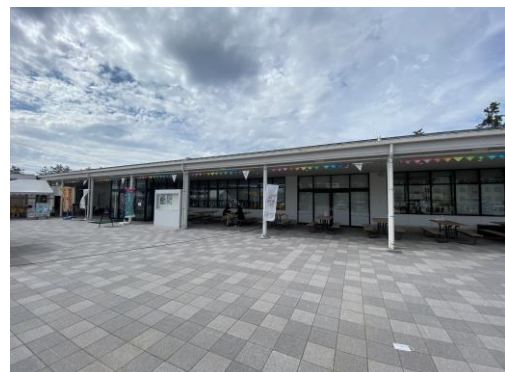
道の駅の外観
