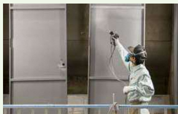
▲仙道さんは塗装を担当。均一な仕上がりを意識してさび止め材を吹き付けます
