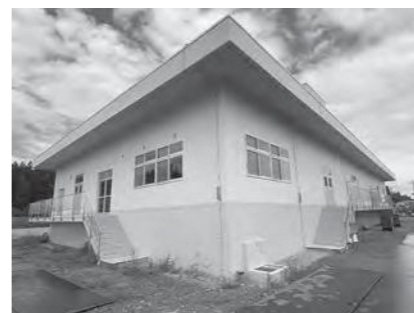
施工不良が発覚した大森浄化センター
