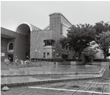
改築予定の横手体育館
