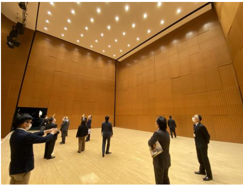
音響反射板が設置された舞台
