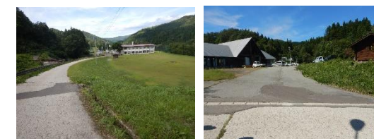
狭隘で、縦断勾配がきつく、冬期利用困難な動線
