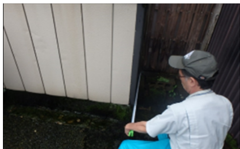
歴史的建造物現況調査状況
