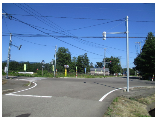
信号機の設置 横手市安本字安本地内 R 1. 7. 2 2
