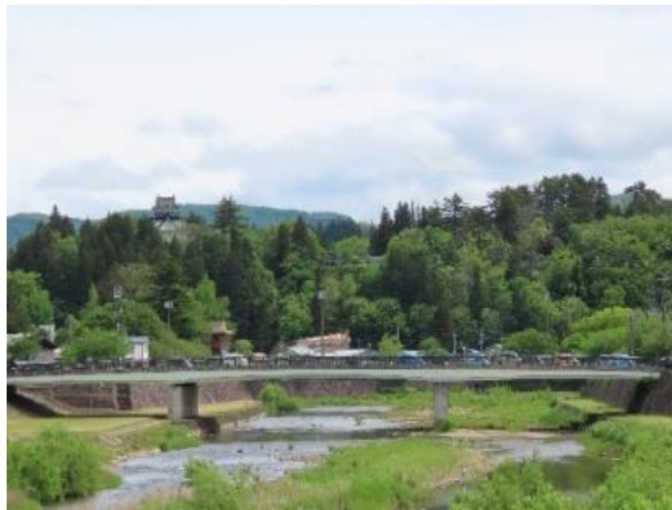
蛇の崎橋の西側からの風景
