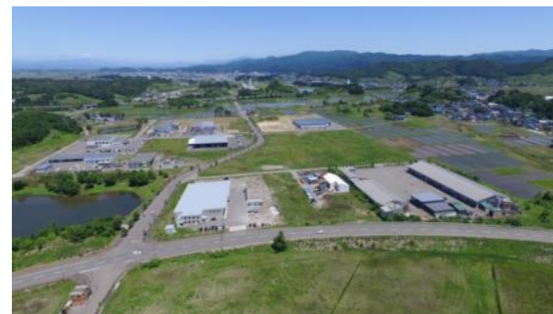
《横手第二工業団地》
