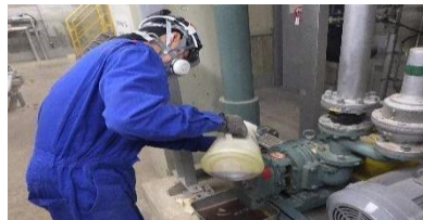
電動機の点検オイル交換
