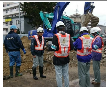
女性職員による現場パトロール
