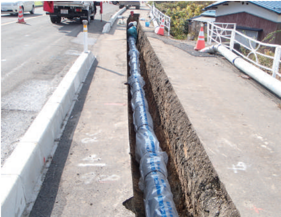
進捗する基幹管路の耐震化(Φ250mm)
