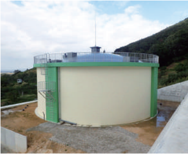
PC造配水池(増田高区配水池)
