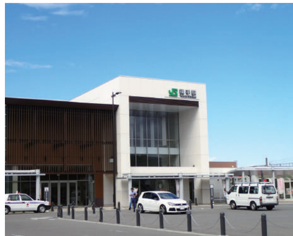
改修された横手駅
