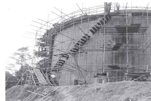
愛宕山高区配水池の建設(昭和47年頃)
