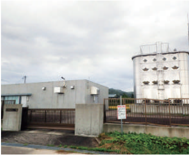
SUS造配水池(馬鞍配水池)
