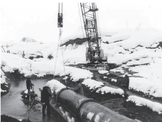
雄物川集水渠の埋設(昭和54年頃)
