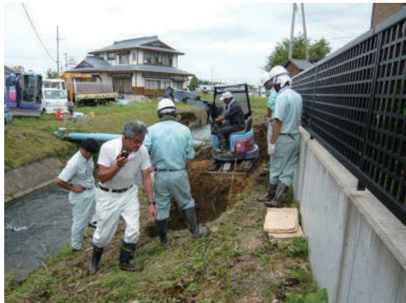
職員出動による漏水修理
