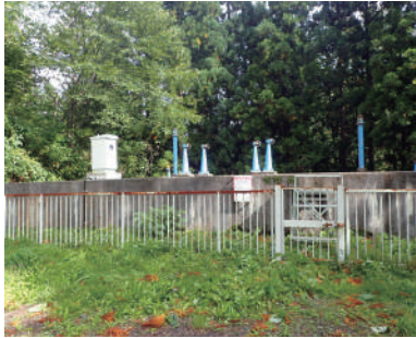
RC造配水池(山内北大松川配水池)
