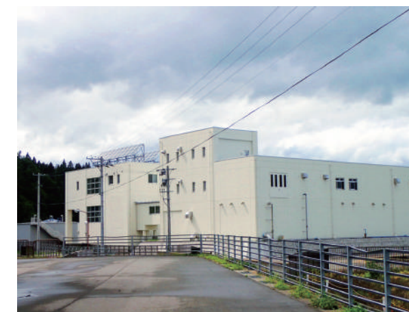
大沢第二浄水場(膜ろ過方式)全景 (施設能力11,800m 3 /日)
